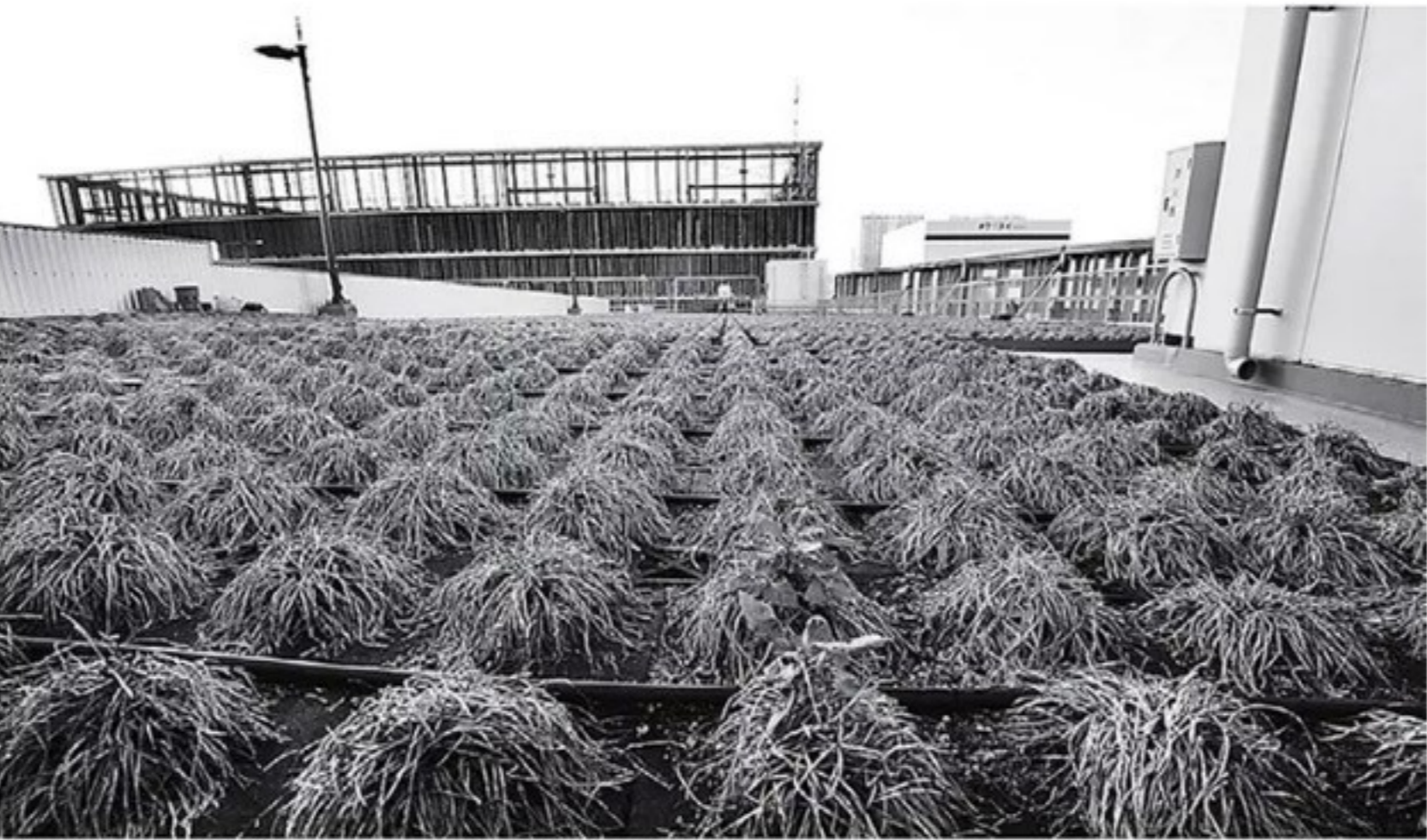
「空白の2年」により、屋上緑化は放置された。枯れ果てた植え草が、市場事業者用駐車場の屋上全面を覆っている
